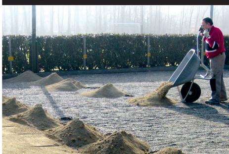
Comience creando una capa de firme en el terreno. Para suelos con fines ornamentales (sin cargas) una capa de arena puede ser suficiente. Si el suelo va a soportar cargas más pesadas (como automóviles o similares), es necesaria una capa base de zahorra. El tamaño de grano más adecuado a utilizar en esta capa es, 0-25 o 0-40 mm. El grosor de capa requerido para una carga ligera es entre 15-20 cm y entre 15-25 cm para cargas medias. Para cargas muy pesadas
