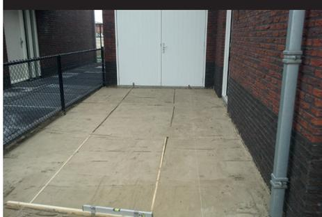
Es aconsejable proporcionar a la capa base una capa niveladora de 3-5 cm, para obtener una superficie lisa. Esto se puede hacer con arena o grava fina (tamaño 0-2 o 0-4 mm). Esta capa también debe ser compactada para una máxima estabilización.
