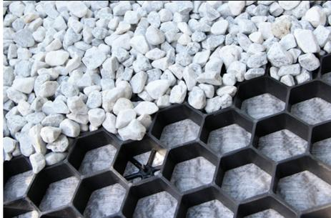
Este es el paso más simple. Deposite la grava o el canto rodado uniformemente en las geoceldas. El grosor de capa requerido es de 5-6 cm, por lo que necesita 1 m<sup>3</sup> de grava por cada 20 m<sup>2</sup>. Distribuya la grava uniformemente hasta que las geoceldas estén completamente cubiertas.
