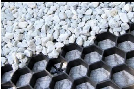
Il s'agit de la partie la plus facile, le gravier ou gravillon peut simplement être éparpillé ou déversé sur les plaques. L'épaisseur de la couche nécessaire est de 5-6 cm. Ainsi, pour 20 m<sup>2</sup> 1 m<sup>3</sup> de gravier ou de gravillon est nécessaire. Ratissez bien le gravier partout de manière à ce que toutes les plaques soient entièrement remplies.
